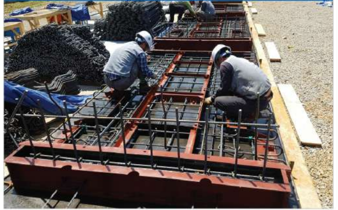
철근 및 거푸집 조립
