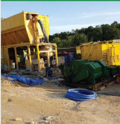
플랜트 조립 및 설치
