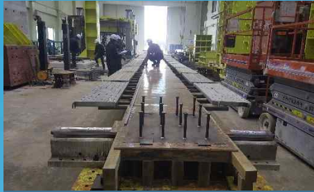
1. 하면 거푸집 설치
