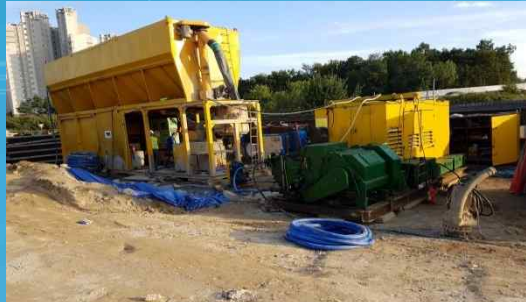
플랜트 조립 및 설치
